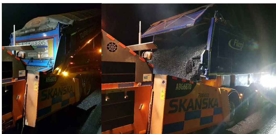
Figur 11. Tillverkning och lossning av asfaltmassa.
