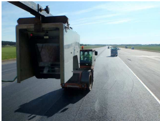
Figur 5. Värmekamera monterad på asfälläggaren.
